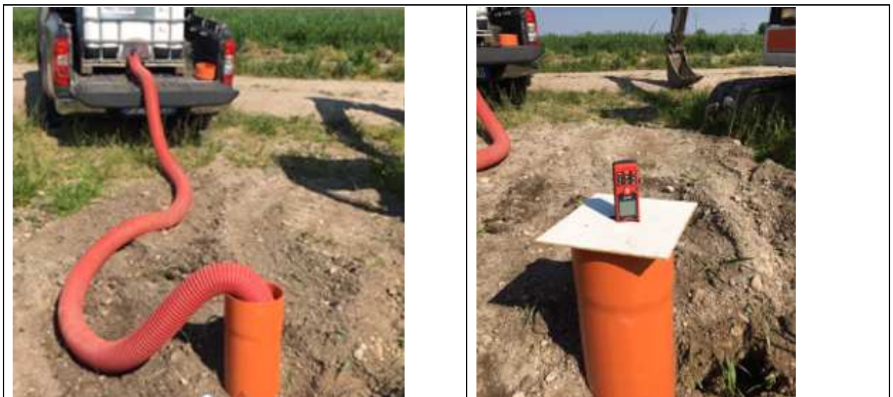
Figura 13 - Predisposizione del pozzetto di prova
