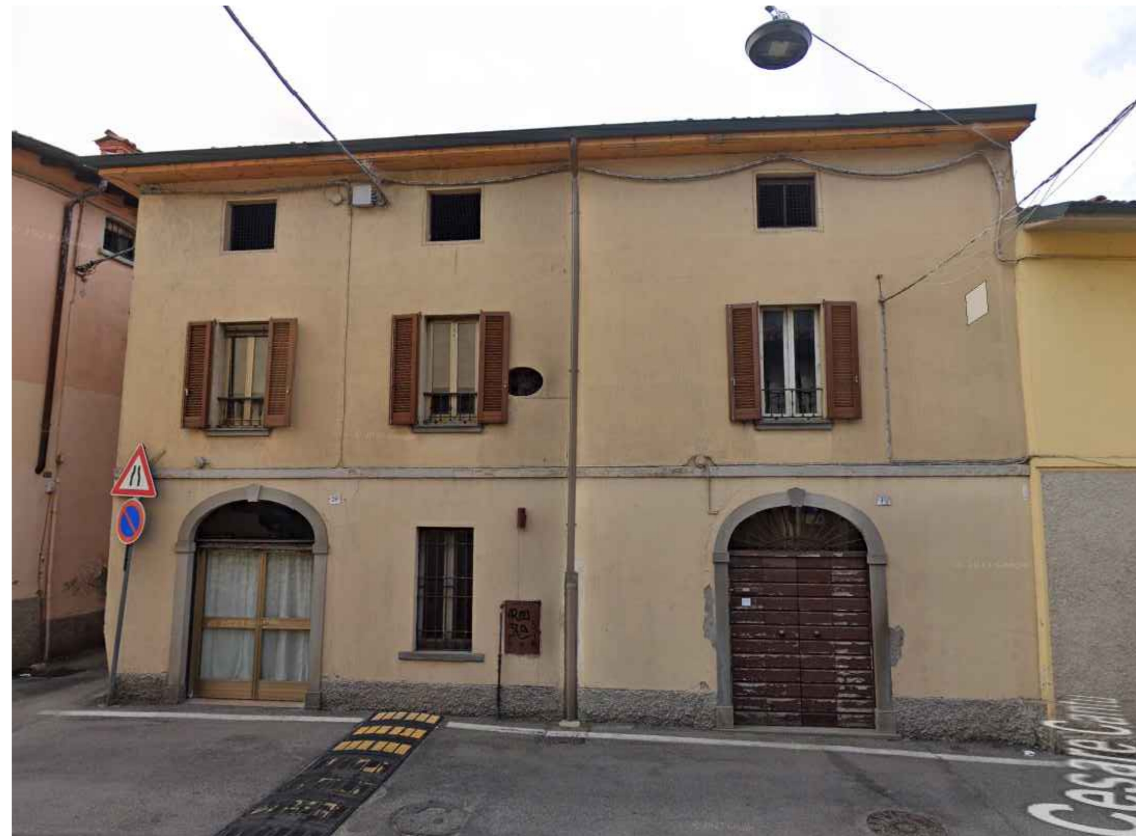
FOTO PROSPETTO NORD
