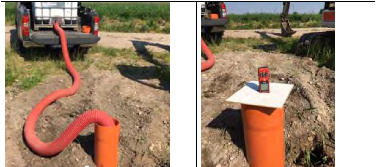
Figura 13 - Predisposizione del pozzetto di prova
