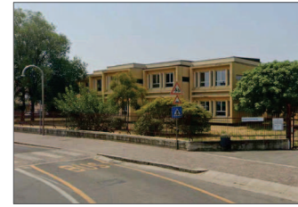
VISTA EDIFICIO OGGETTO DI INTERVENTO Via Solferino, 45 - 25038 Rovato (BS)
